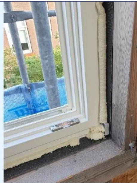
figuur 10: PUR rondom kozijnen
