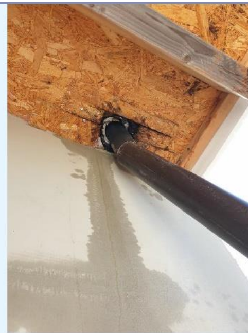
figuur 12: Doorvoer voor HWA aan achterzijde
