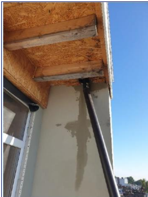
figuur 11: Doorvoer voor HWA aan achterzijde
