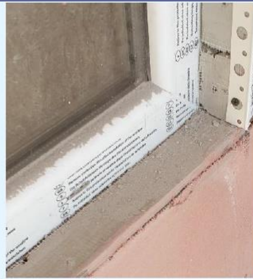
figuur 19: Buitenaanzicht van kozijn waar vocht in de constructie zal trekken.
