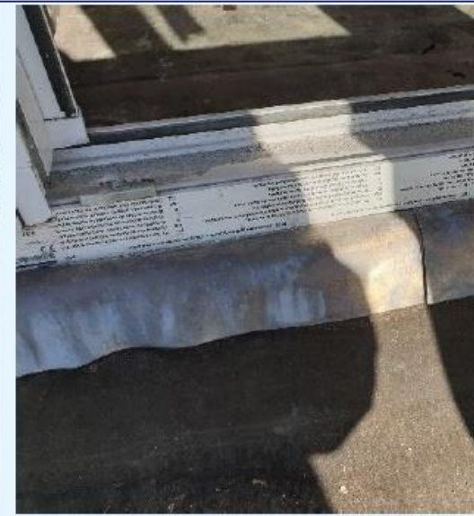
figuur 20: Onderregel bij deur waar geen ontwatering uit het profiel mogelijk is.
